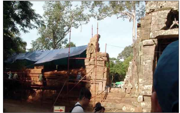
△ 타프롬 사원 성벽을 복원 중인 작업 장면
